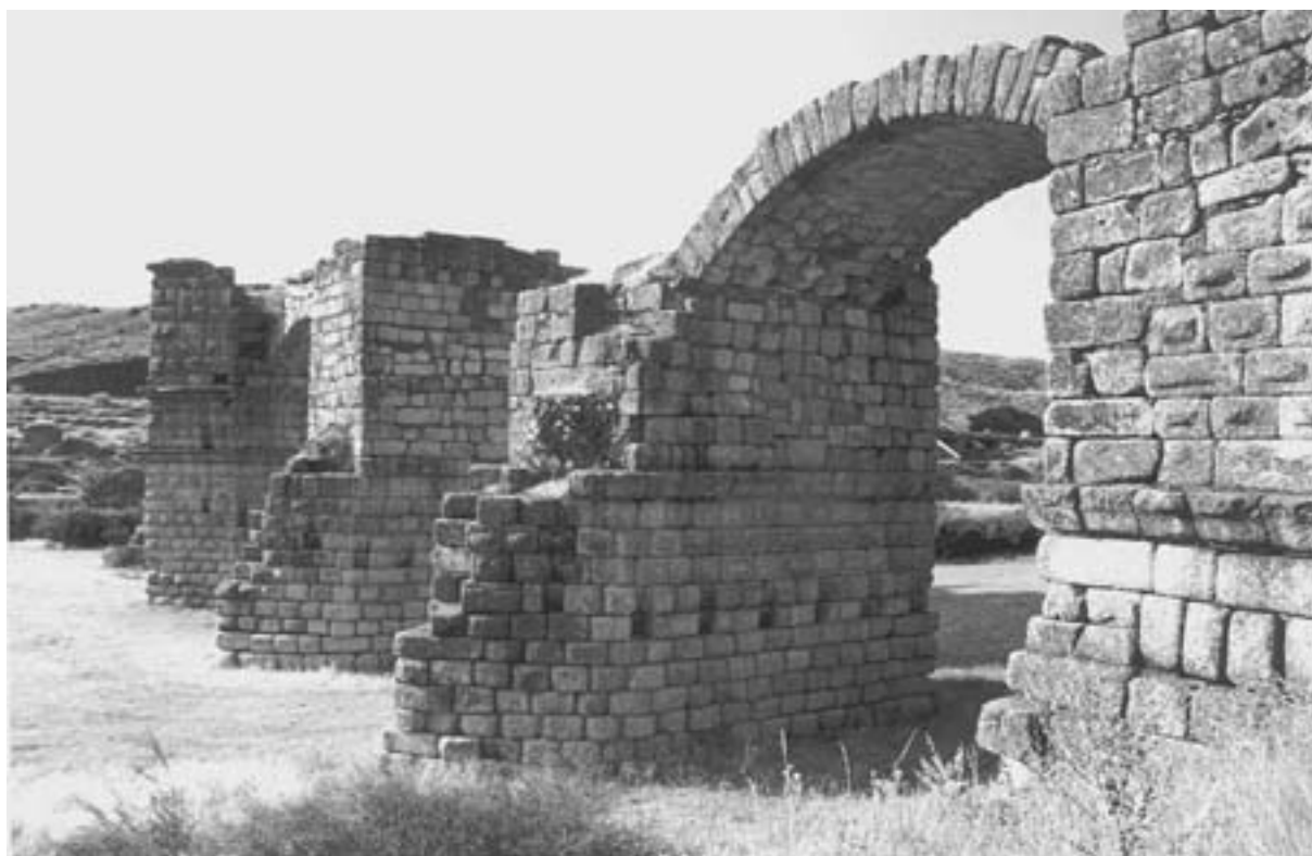
Fig. 3. Puente de Alconétar. Pilas y arcos junto al estribo derecho. Vista aguas arriba.
