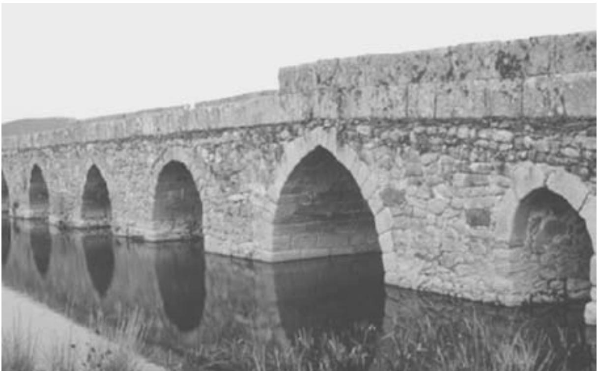
Fig. 2. Puente Mocha sobre el río Salor. Arcos centrales. Vista aguas abajo.
